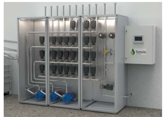
Voorbeeld van een CDU voor 3 diverse reinigingsmiddelen en 9 diverse afnamepunten
